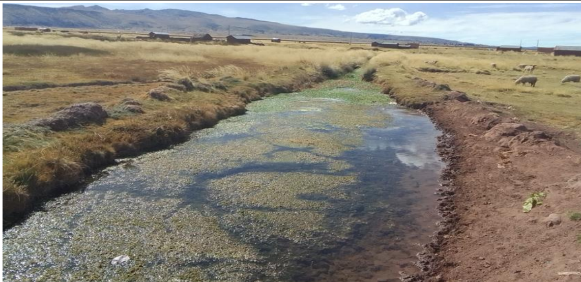
FIGURA N°01: TRAMO CRÍTICO QUEBRADA HUILACAYA, PRESENCIA DE VEGETACIÓN DENTRO DEL CAUCE.
